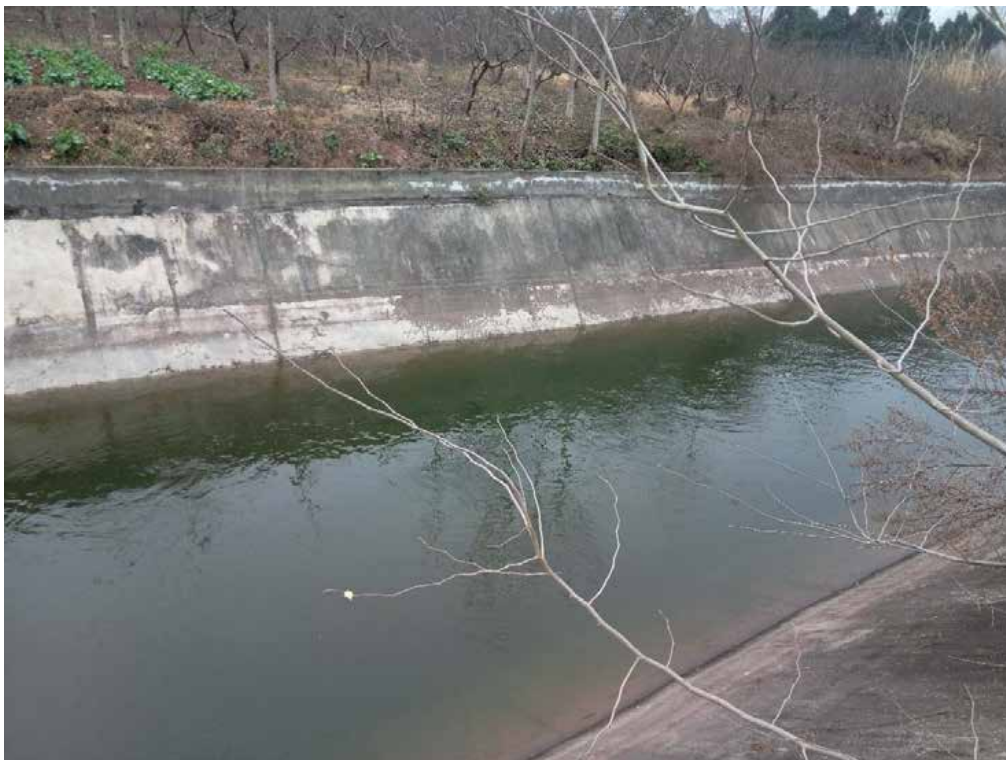
赵家分干渠渠道
