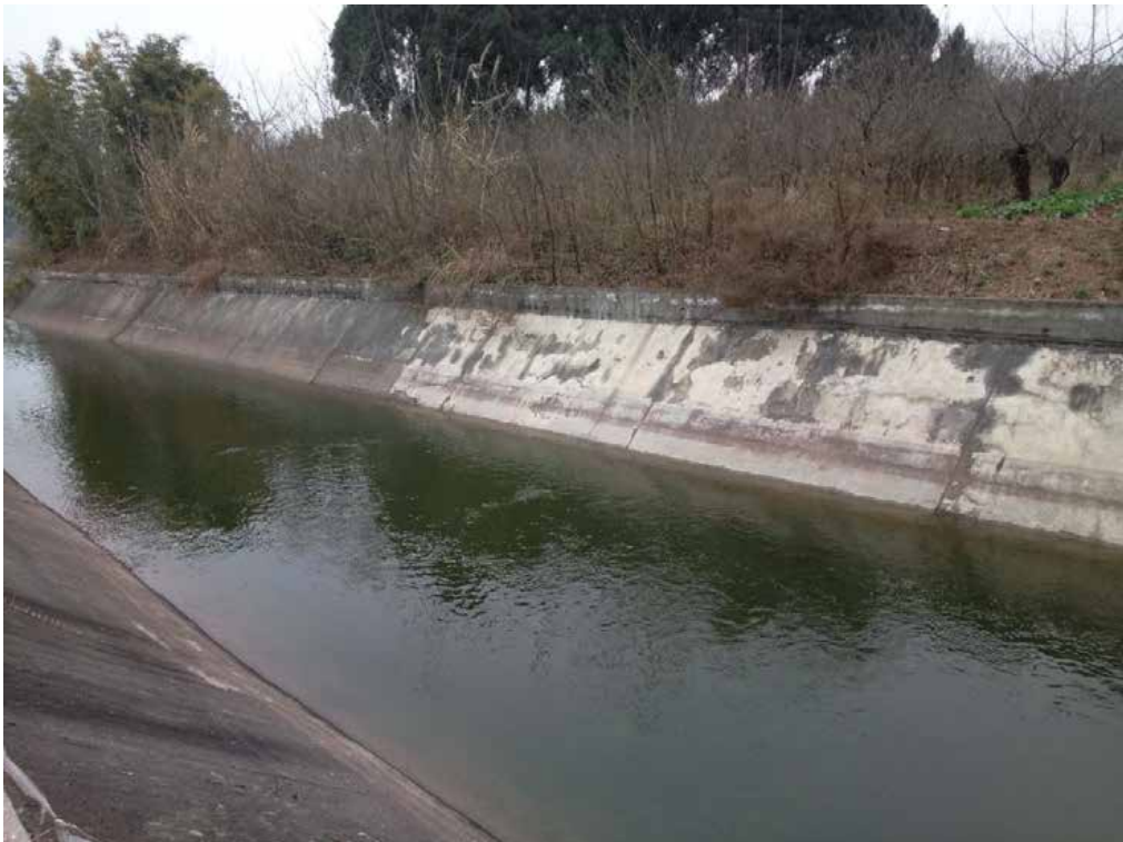
赵家分干渠渠道
