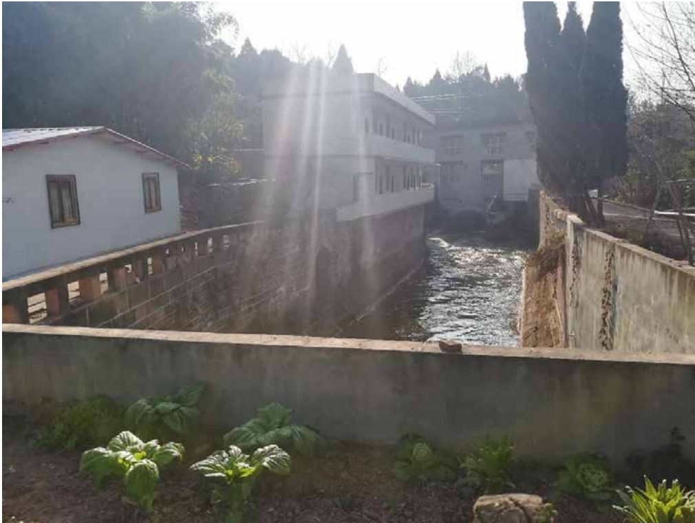
赵家分干渠取水口
