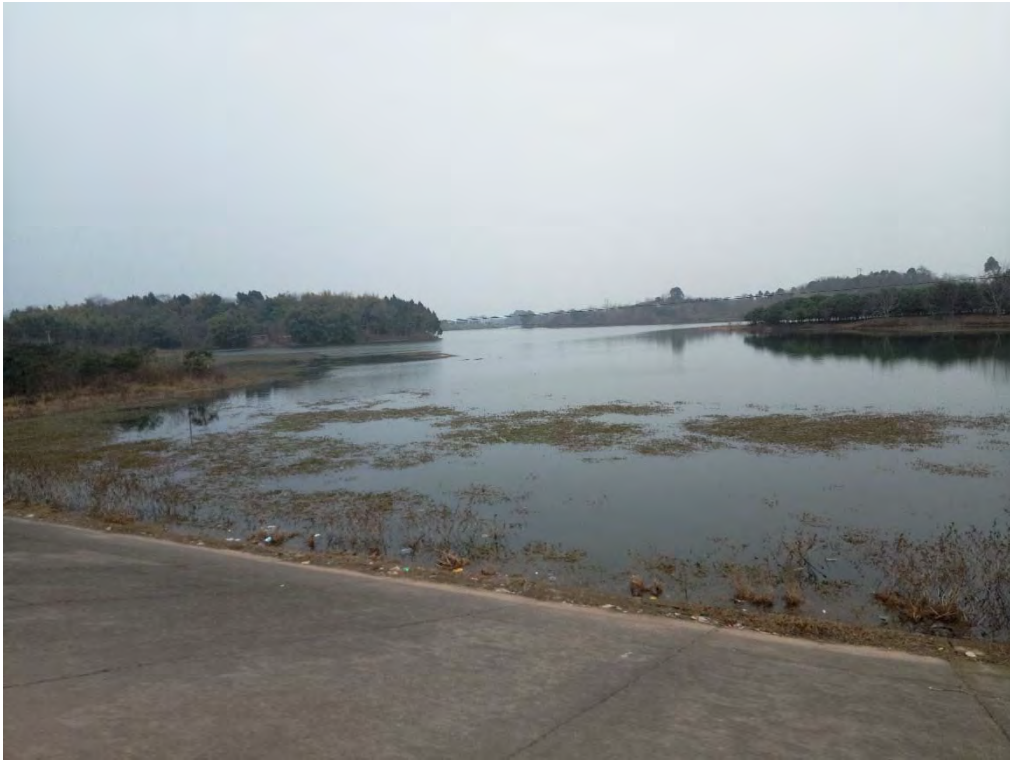
低南干渠取水口
